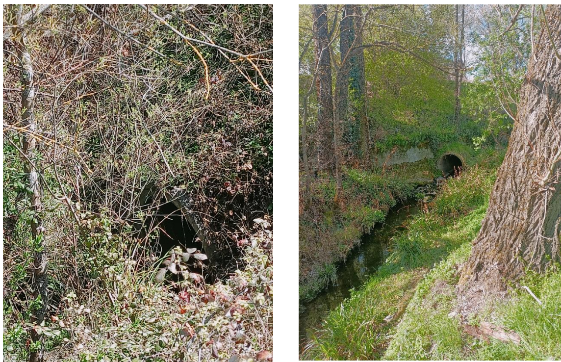
Figura 2.3 – A sinistra, la sezione di monte del tombamento lungo il T. Sorrasa; a destra, la sezione di valle del medesimo tombamento
