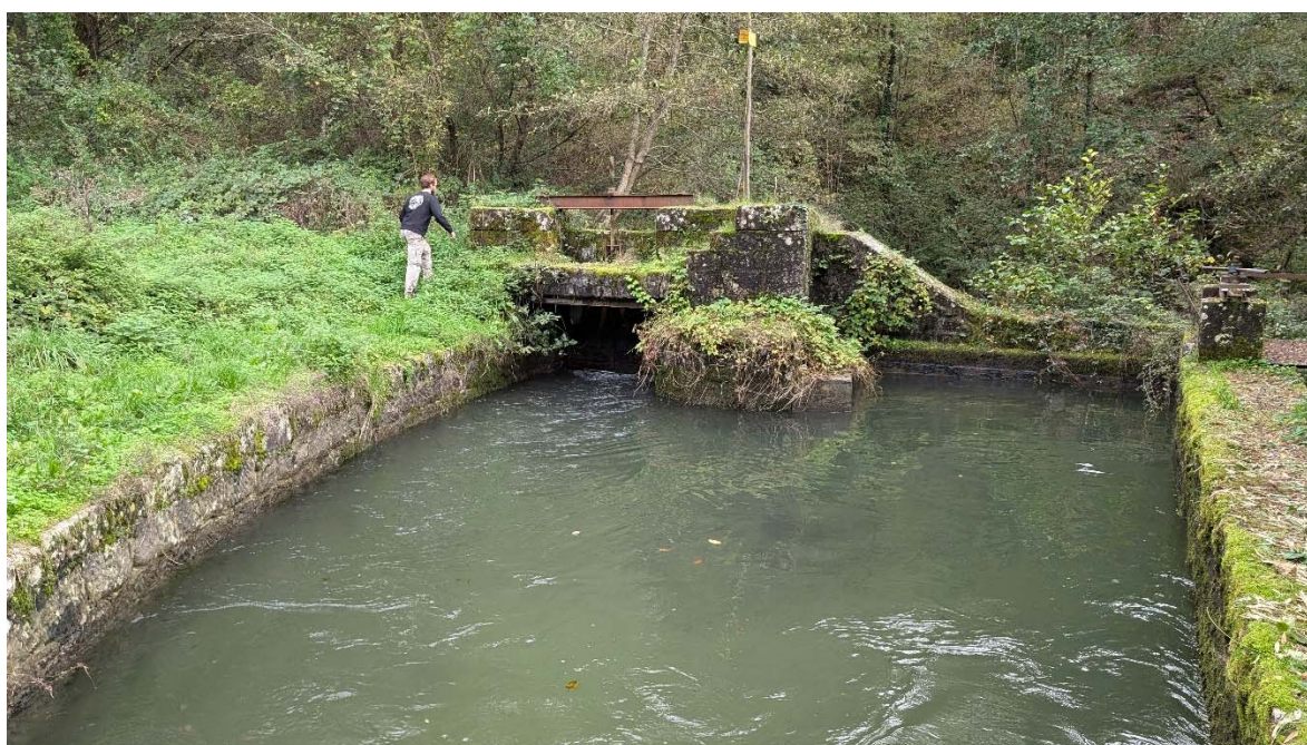
Figura 7.17 Opera di presa sul T.Staggia - paratoia mobile
